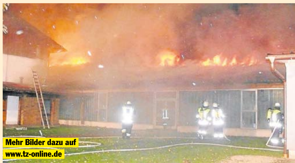
Flammen lodern im Verbindungstrakt zwischen Turnhalle und Klassenräumen
